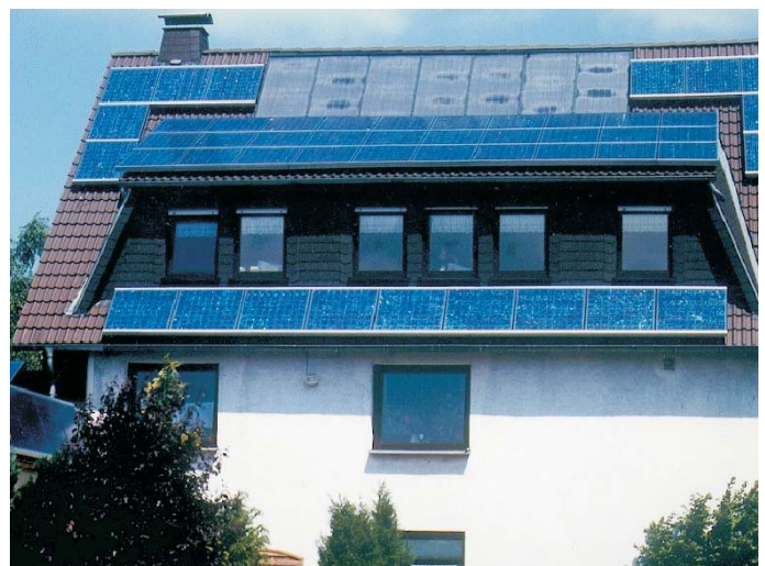
Abb. 5.1: Zwei-Familienhaus mit Fotovoltaik- und Solarthermie-Modulen auf dem Dach
